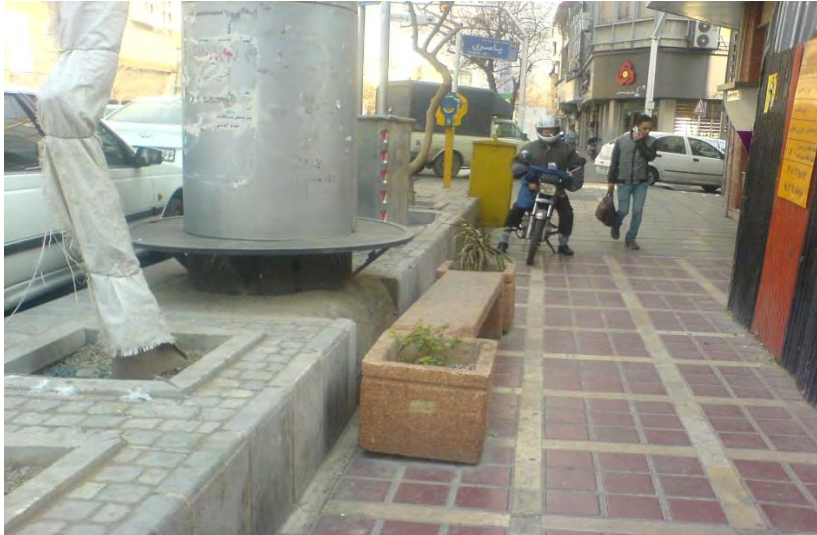
شکل 7: سکوی بکار گرفته شده بر روی آبرو
